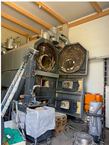
Brennkessel links und Abgasreinigungsanlage rechts
