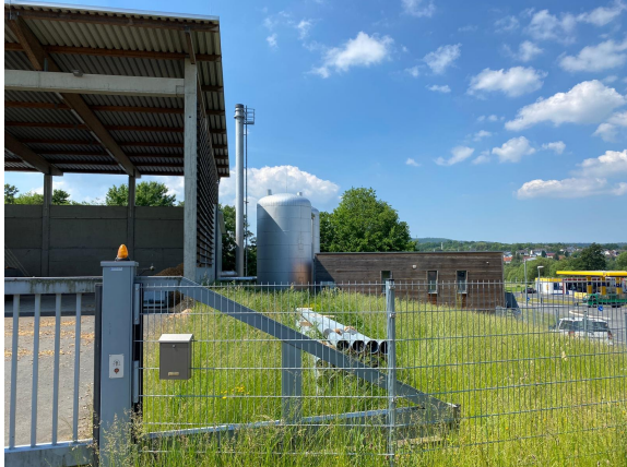
Ansicht der Anlage mit Hackschnitzellager links, im Hintergrund Pufferspeicher und Betriebsgebäude
