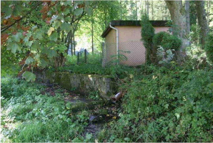
Abb.2: Wallbrunnen mit Trinkwasserfassung.
